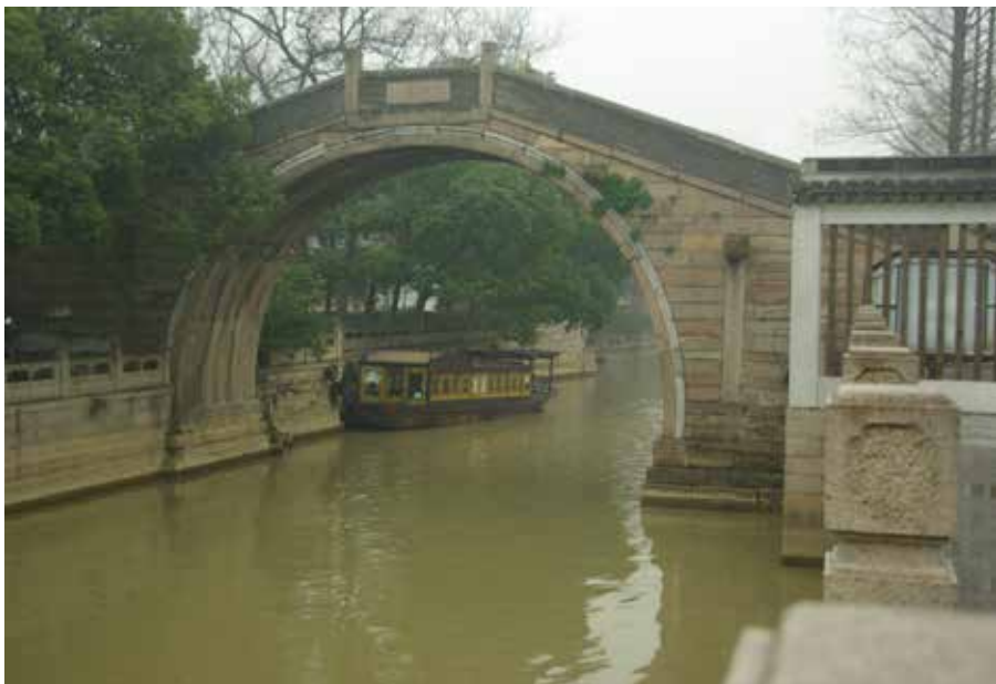
Mostek we wspaniałych ogrodach w Suzhou, tuż obok Wielkiego Kanatu
